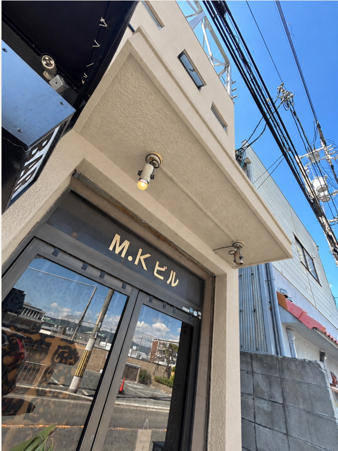
入口：ひさしと外壁の質感
