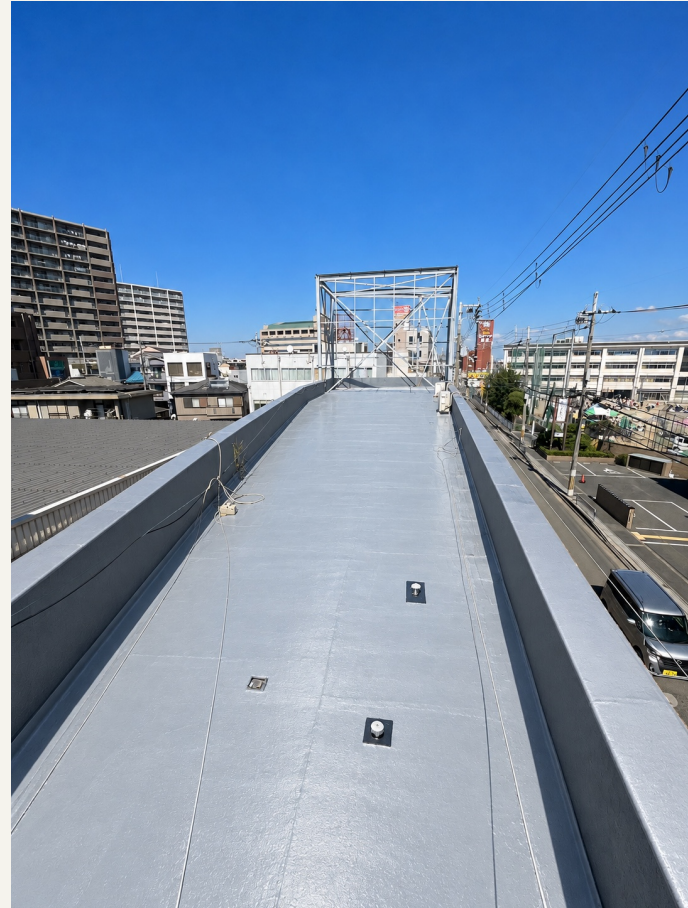
屋上：既存の設備と形状を残して
